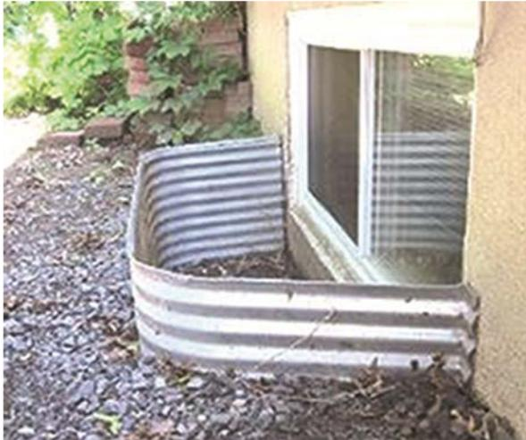
**Déficiences possibles :** Margelle à égalité avec le terrain ou plus basse, mauvais drainage.
