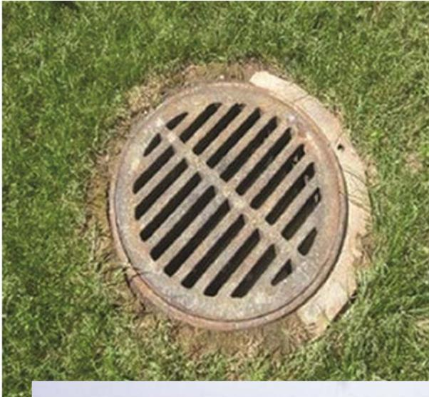
**Déficiences possibles :** Grille bouchée par des débris ou de la végétation ainsi que le drainage à l'entrée d'un garage partiellement obstrué par de la végétation
