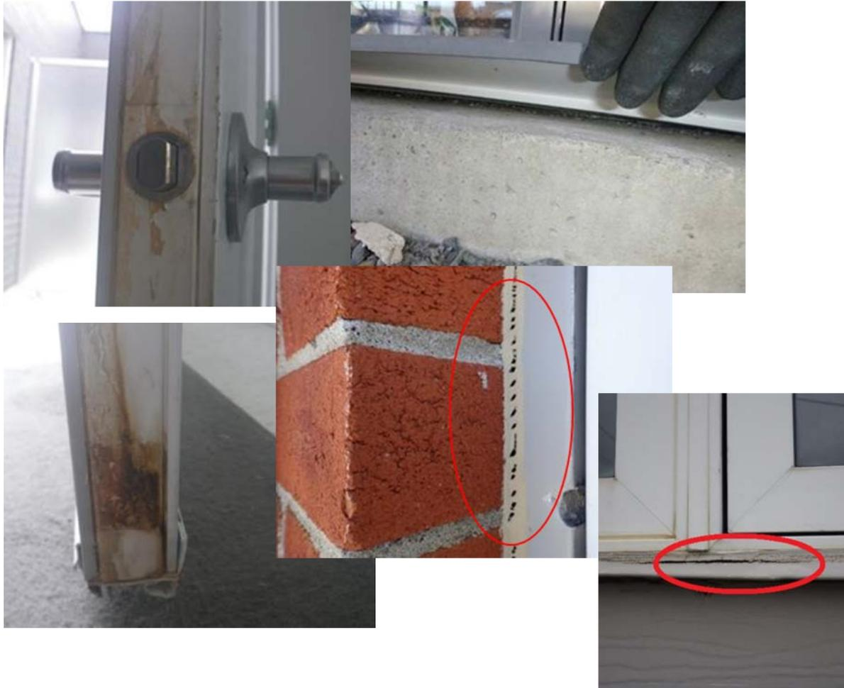
**Déficiences possibles :** Les fenêtres comportent plusieurs pièces qui sont assemblées mécaniquement et étanchées par un joint de scellage. On en retrouve également au pourtour de l'ouverture, à l'extérieur. Ces scellages doivent toujours être en bon état, ne doivent pas être fissurés ou desséchés.
