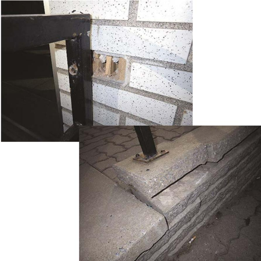
**Déficiences possibles :** Dû au mouvement du sol, les rampes d'accès ne doivent pas présenter de désordre significatif. La solidité des garde-corps ne doit jamais être négligée; des normes précises existent pour mesurer la résistance structurale des garde-corps et main courante. L'ingénieur peut mesurer la résistance de celle-ci et ainsi confirmer leur conformité. La structure principale des escaliers et des rampes se doit d'être entretenue périodiquement
