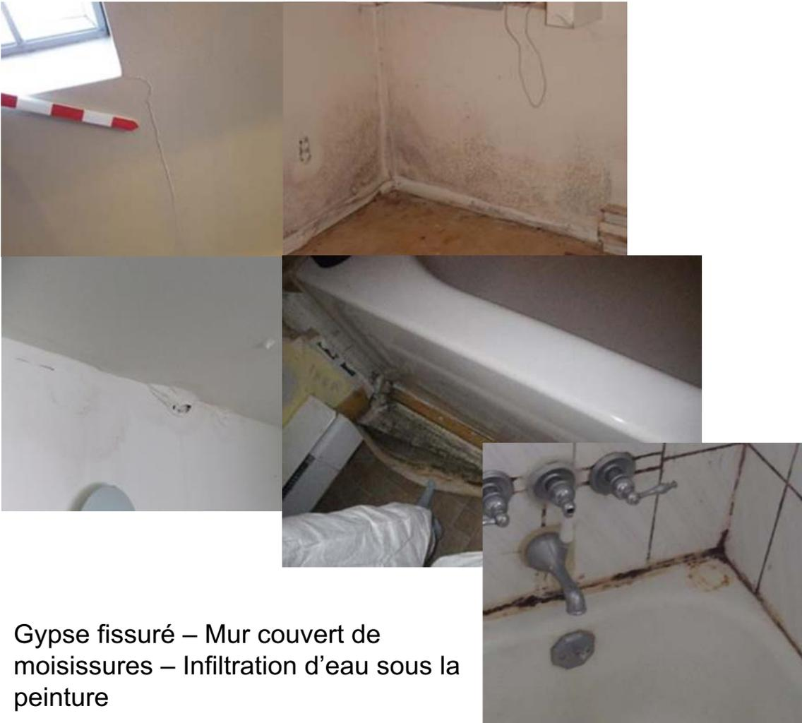
Gypse fissuré – Mur couvert de moisissures – Infiltration d'eau sous la peinture
