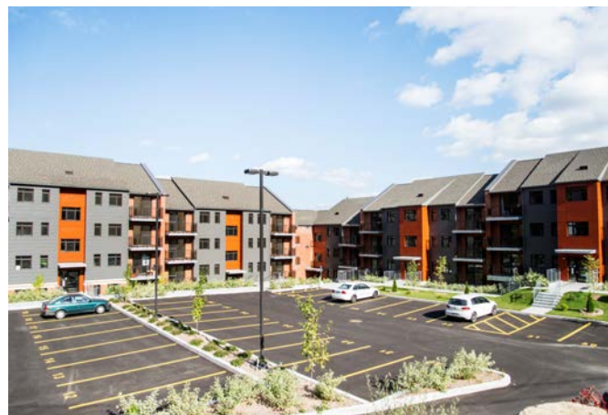
40 logements familiaux Sainte-Adèle Construction 2014
