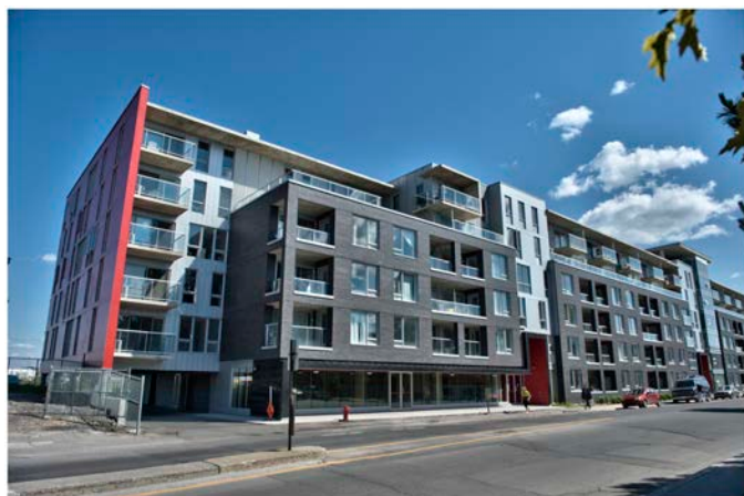
Résidence pour personnes âgées 2930 Ontario Est, Montréal Construction 2013
