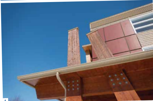
1 La résidence Gérard-Blanchet, un OSBL d'habitation pour aînés à moyen ou faible revenu, est située à Desbiens au Saguenay-Lac-Saint-Jean. C'est le premier immeuble à logements multiples au Québec à être entièrement construit à partir de panneaux de bois lamellé-croisé.
